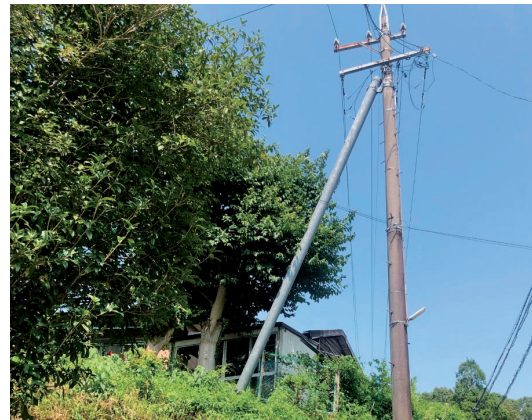
自在型鋼管組立支柱
