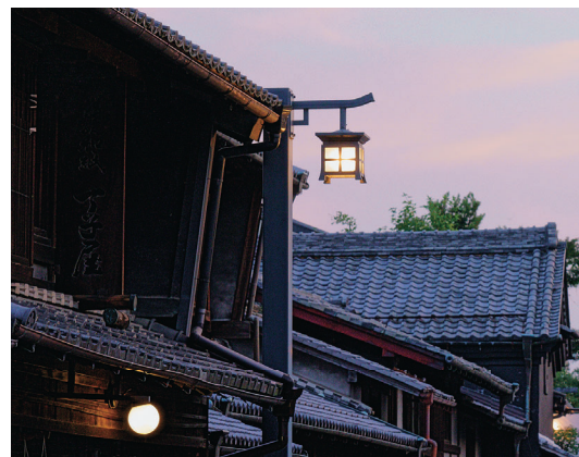
街路灯柱(低圧地中線用)
