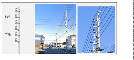
防護管を取付する高圧線の両側の電柱の装柱が異なる場合
